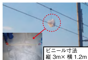
電線に引っ掛かった 建設用ビニール
