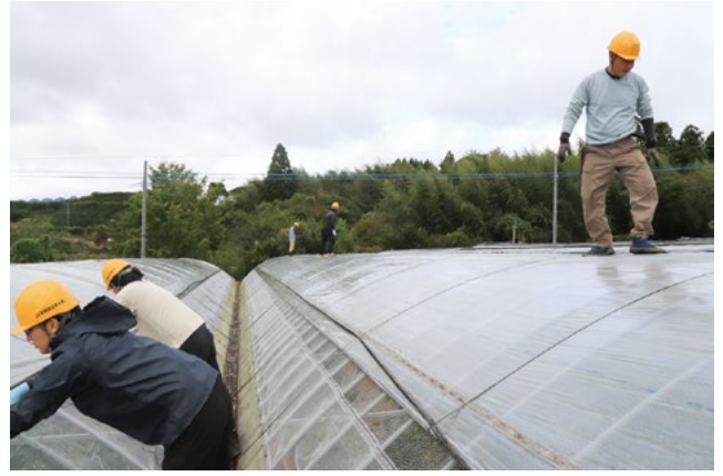
ビニール被覆作業をする部員ら
