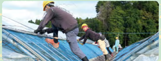
青年部によるハウスのビニール被覆支援。
